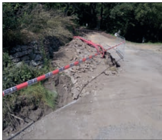
Výkopové práce pro nové elektrické vedení
